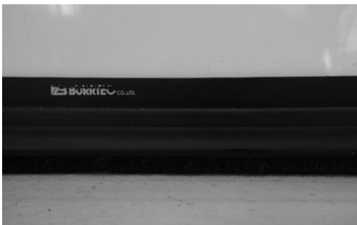
ドア下に取り付けられたバーテック製の防虫ブラシ。写真では 分かりにくいですが、長くて丈夫なブラシが床にピッタリと あたって虫の侵入を防いでくれます。
